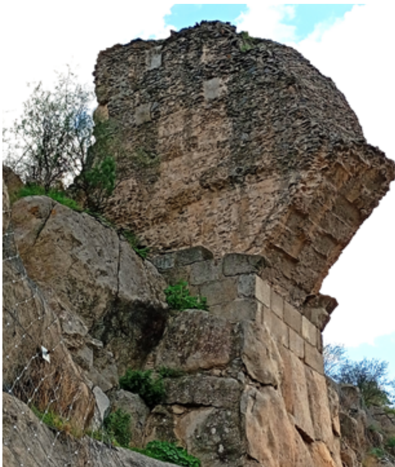
Fig. 6. Restos del puente-acueducto en la margen oriental del Tajo (fotografía: Grupo ARCYT).
