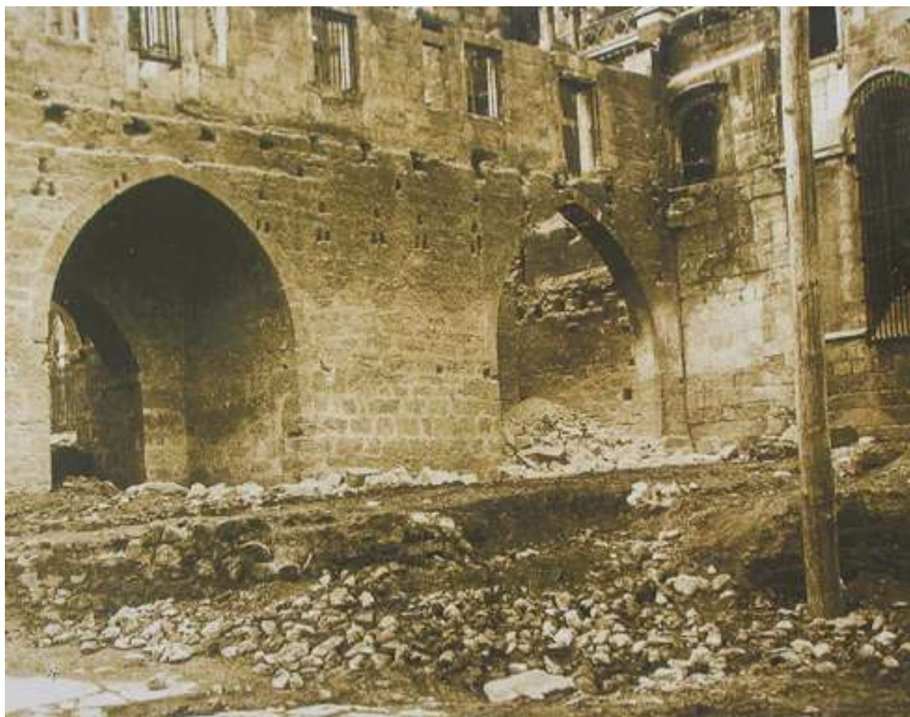
Fig. 6. Puerta Obispo en el momento de su demolición (1910-11) (Foto: Fototeca Municipal de León).
