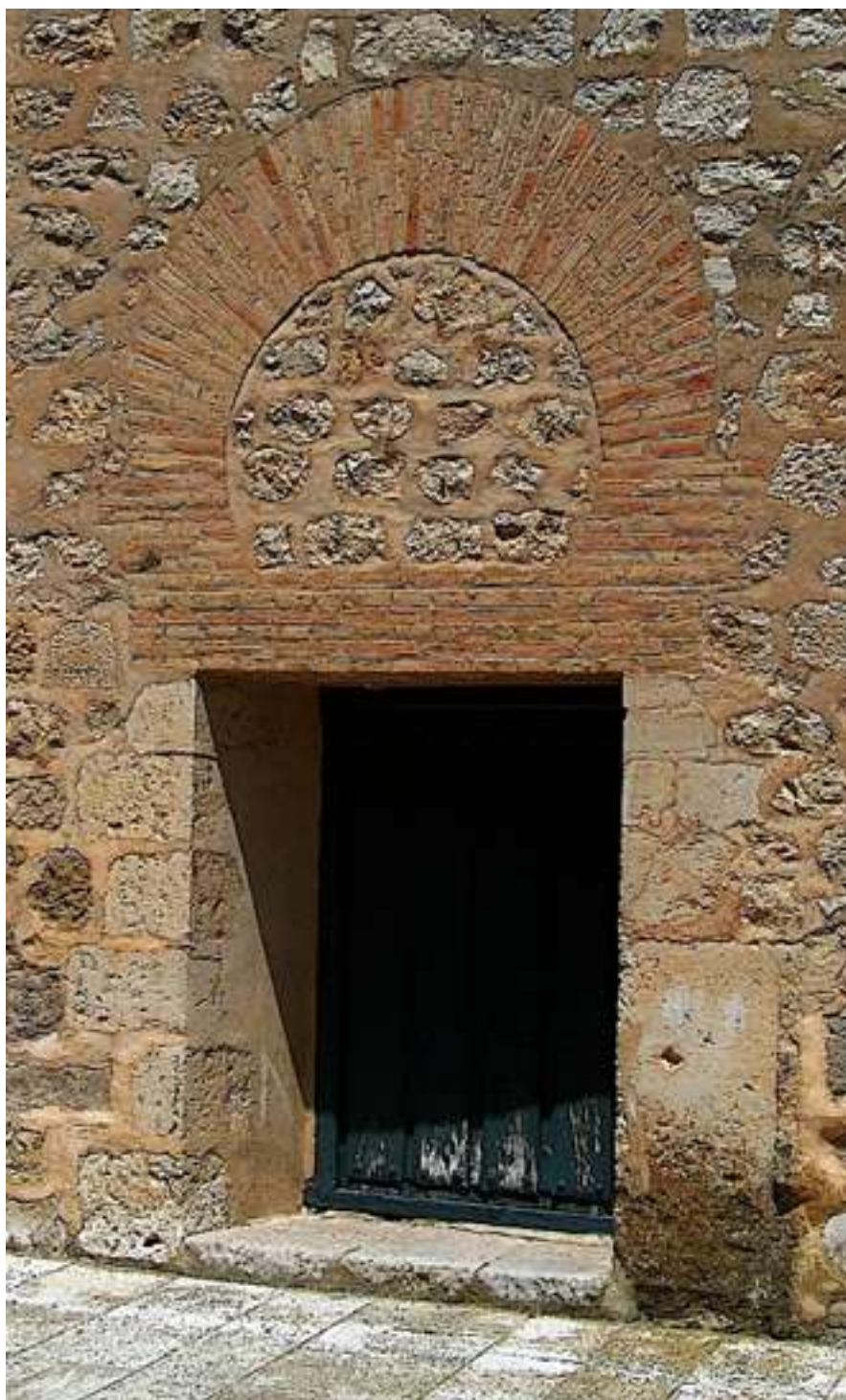
Fig. 6 Acceso al interior de la iglesia de San Cebrián de Mazote (Valladolid) por el brazo sur del transepto (Fot. Autor). Aunque el edificio ha sufrido importantes reconstrucciones en el siglo XX (1930-1940), su lenguaje arquitectónico muestra una clara vinculación con lo cordobés. Incluso su historia aparece vinculada al sur de la península, pues al igual que ocurre con San Miguel de Escalada y San Martín de Castañeda (Zamora), los monjes y socios que se establecieron en Mazote también procedían de Córdoba.
