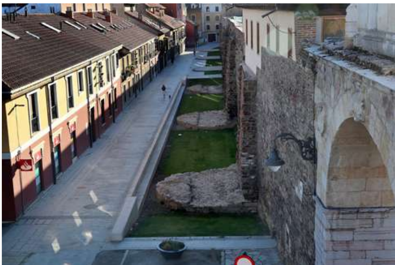
Fig. 12. Vista actual de la muralla tardorromana en calle Carreras. Lienzo norte. Confrontar con la Fig. 8 (Foto: Fototeca Municipal de León).
