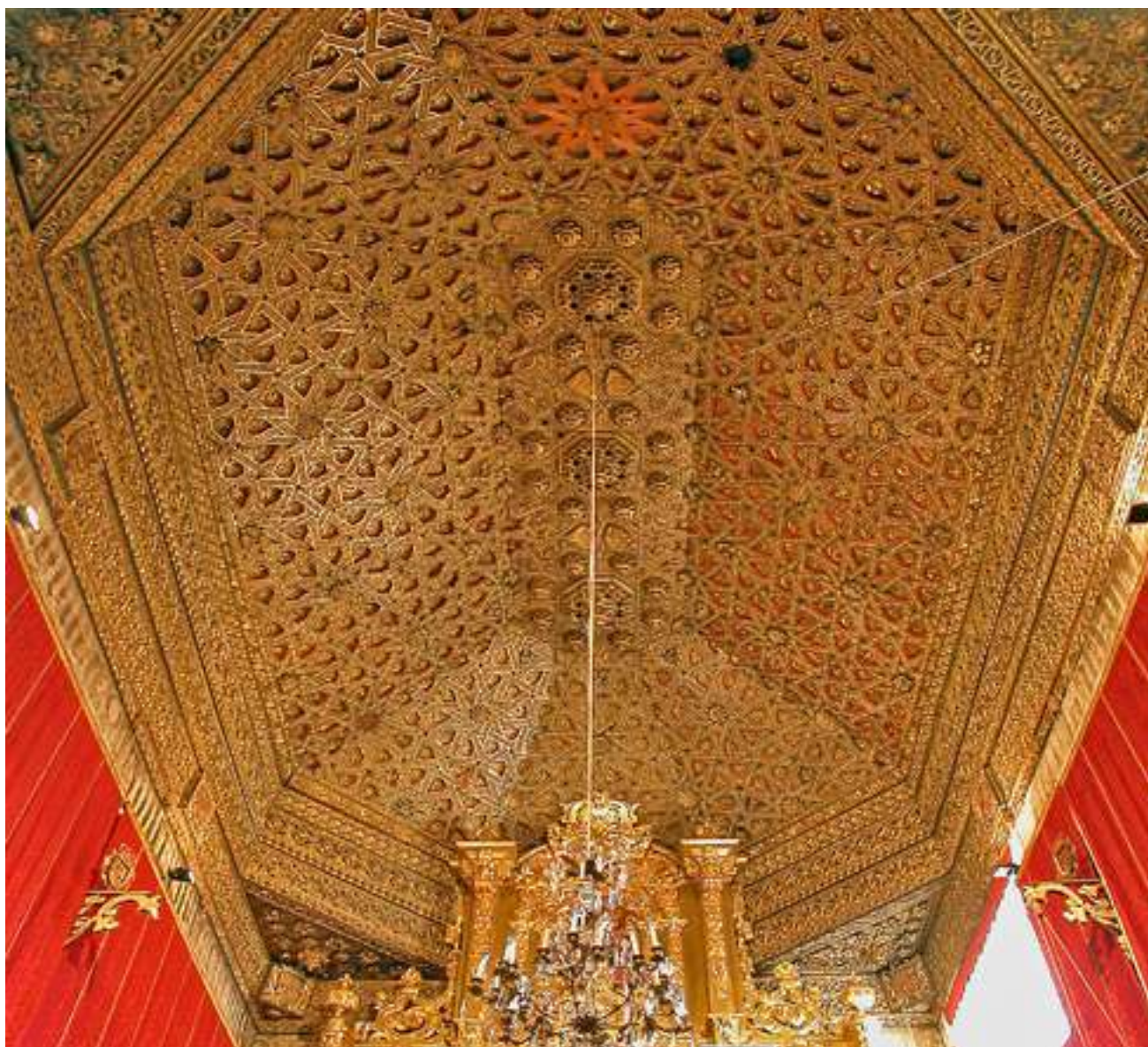
Fig. 9. Armadura de lazo de diez de la iglesia del segoviano convento de San Antonio el Real. Las ruedas de lazo características del arte islámico ya se han incorporado totalmente en la carpintería cristiana. (Foto: Autor.)
