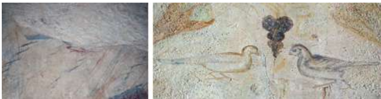
Fig. 40. Izqda.: detalle de la enjuta sur con restos de ave. Dcha.: La paloma de la izquierda permite identificar al ave presente en la enjuta. La pintura está abrasada, como la mayor parte localizada en el arranque de bóveda sur, debido a una restauración desastrosa realizada en los años veinte 40 , y no permite una mejor identificación del color. Enfrentado a esta paloma se encuentra un ejemplar macho.
