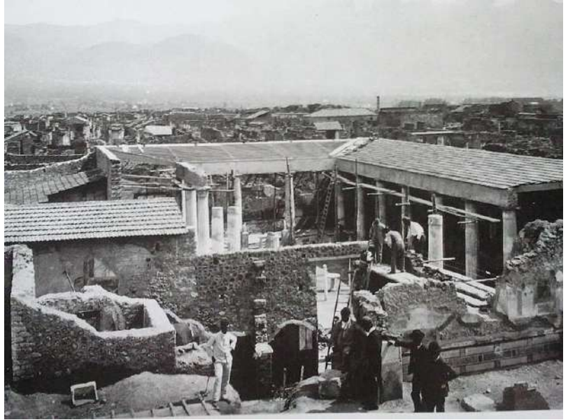
EXCAVACIONES EN POMPEYA EN 1895, CASA DEI VETTI
